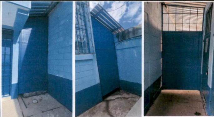
Foto 3: Substitucion de Puertas.
