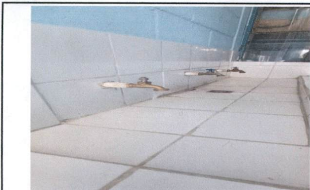
Foto 9: Instalación de Chorros.
