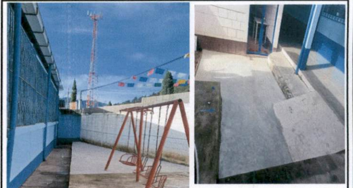
Foto 4: Substitución de losa en patios.
