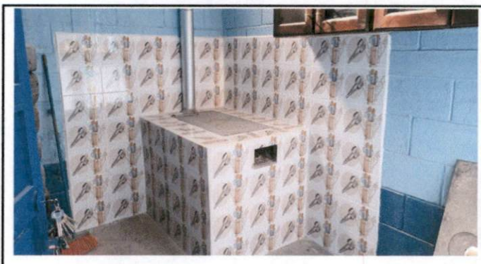
Foto 10: Substitución de chimenea de metal, plancha e instalación de azulejo en estufa rural.
