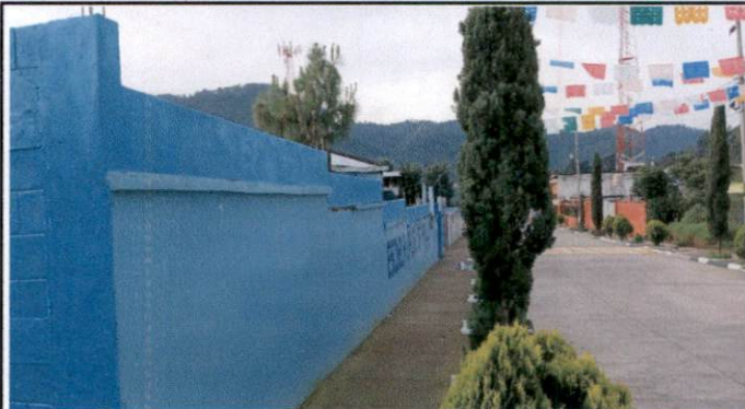
Foto 14: Pintado parte superior de la pared de circulación exterior.
