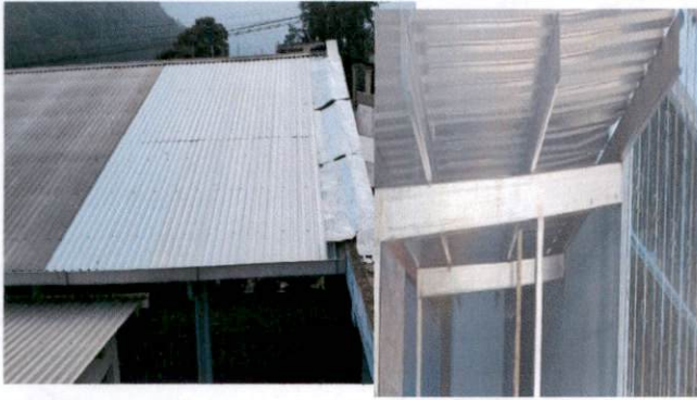
Foto1: Substitución de lamina .
