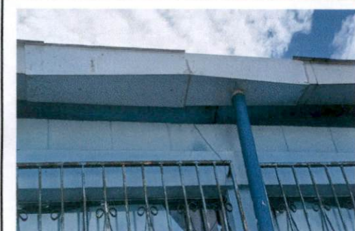
Foto 11: Instalación de canal para agua pluvial.
