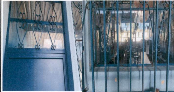
Foto 12: Substitución de vidrios.
