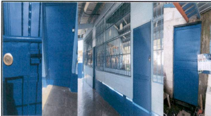
Foto 7: Substitución de chapas y mantenimiento de puertas.
