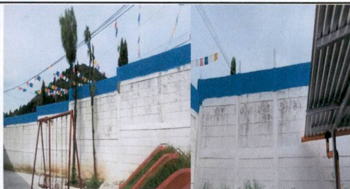
Foto 15: Pintado de la parte superior de la pared de circulación interior.
