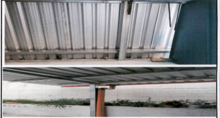
Foto 2: Substitución de estructura de soporte de madera por metal.
